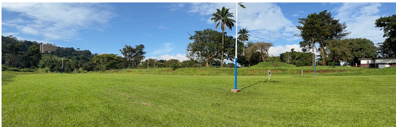
Le terrain sur le practice du Golf de Yaoundé et les premiers poteaux solaires.
